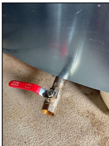
4.5 - Repérer et tracer l'axe de la tubulure de vidange
