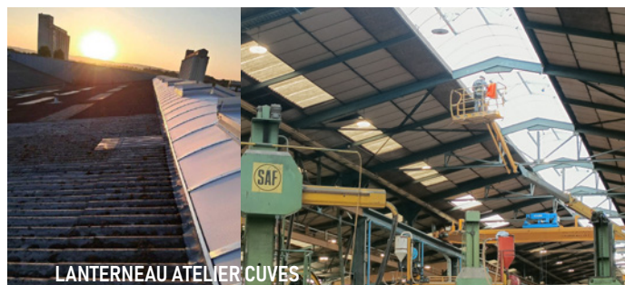
LANTERNEAU ATELIER CUVES
